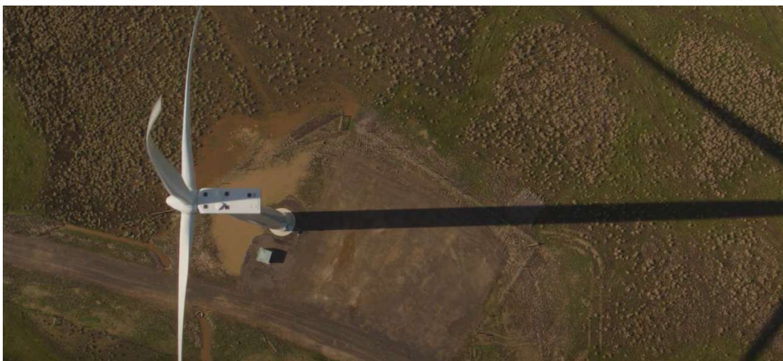
Фигура 1.1.2.3-1. Примерно извършване на строително-монтажните работи
