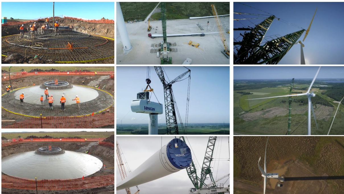
Фигура 1.2.2-1. Примерно извършване на строително-монтажните работи
