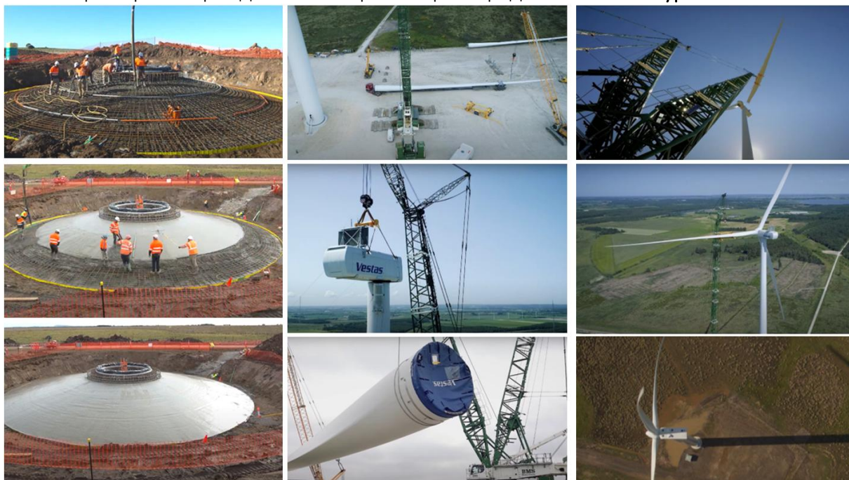
Фигура 4. Примерно извършване на строително-монтажните работи
